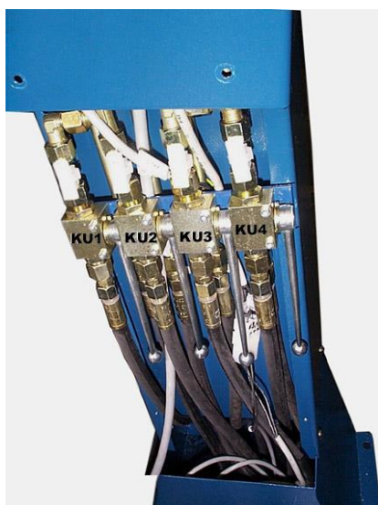
kuva. 2: palloventtiilit nostimen tasaamiseen.
